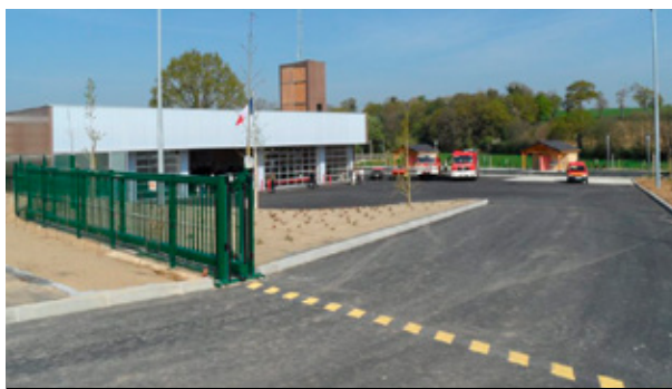
Centre de secours de Châteaugiron
